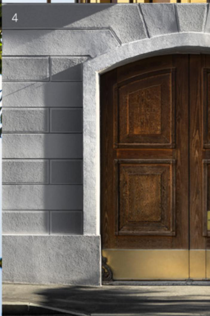
**Dettaglio 1:** Ricostruzione del bugnato fascia di base facciata principale;
