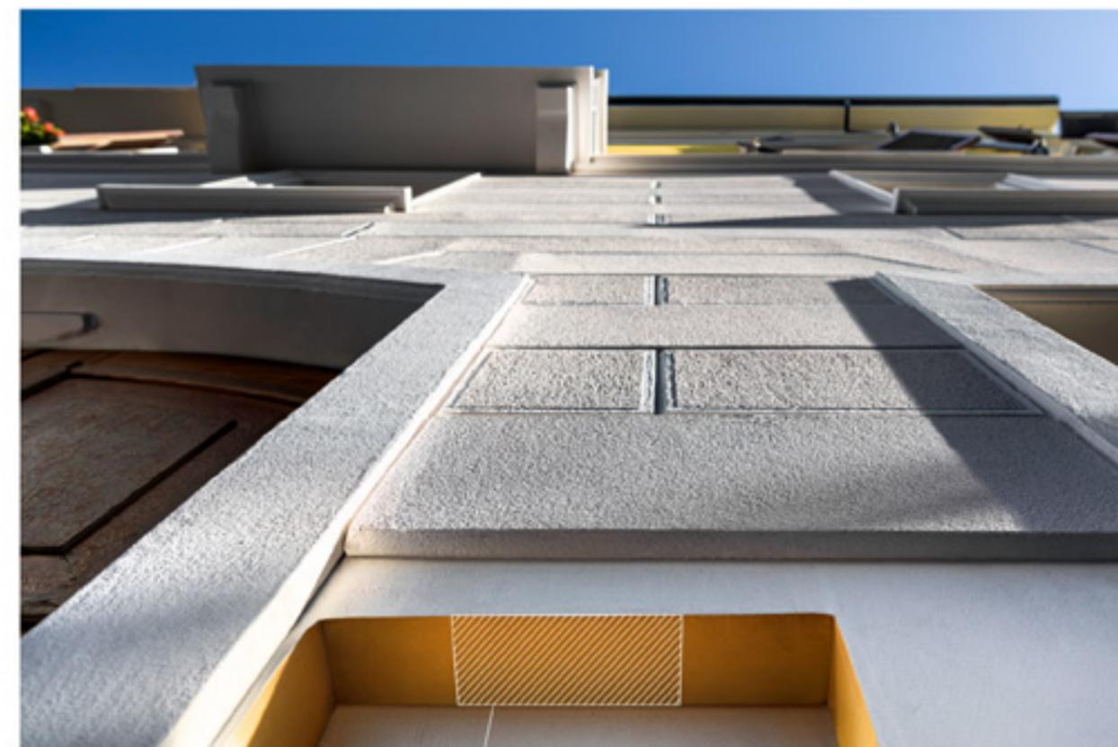
**Dettaglio:** Particolare pannello cappotto in pannelli rigidi in schiuma Polyiso espansa e pannelli in EPS per ricostruzione bugnato
