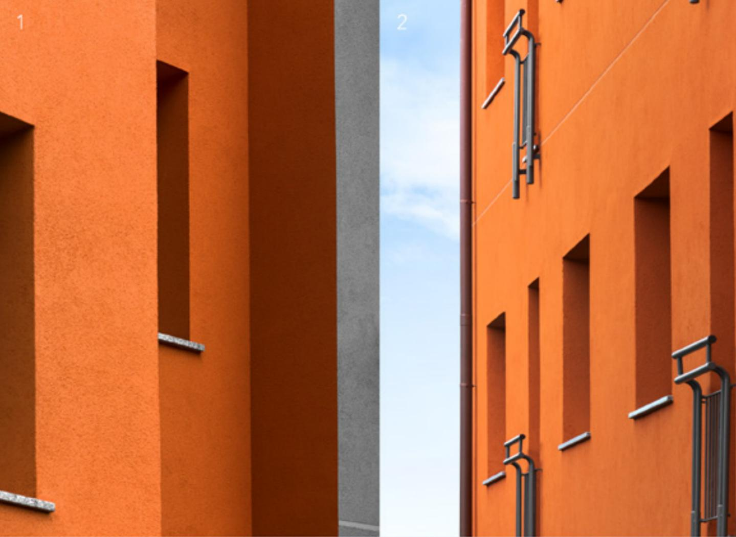
**Dettaglio 1:** Particolare finitura cappotto in pannelli schiuma Polyiso espansa.
